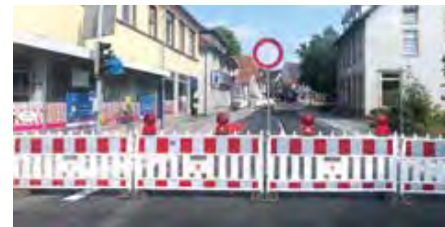
Die Sperrung ist Vergangenheit: Das Teilstück der Lange Straße ist wieder für den Verkehr freigegeben.
